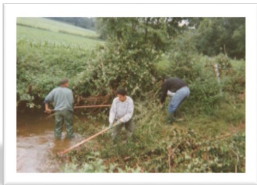
Visite des chantiers Loire Service Environnement 1995
